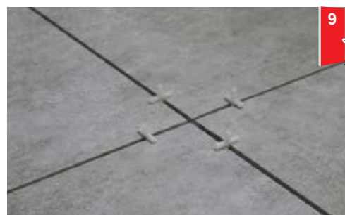
• استفاده از اسپیسر (صلیب) جهت دستیابی به بندهایی با عرض یکسان
