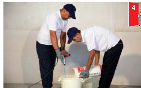
• آماده کردن چسب با استفاده از میکسر
