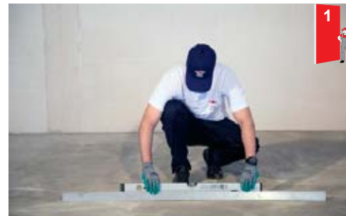
• کنترل تراز بودن و هموار بودن سطح زیر کار
