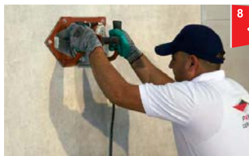
• استفاده از ویبراتور (یا ماله لاستیکی) جهت اطمینان از چسبندگی مناسب اسلب به سطح زیر کار و نیز خروج هوا
