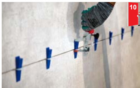
• استفاده از کلیس و گوه همترازکننده جهت اطمینان از هم سطح بودن سرامیک‌های مجاور
