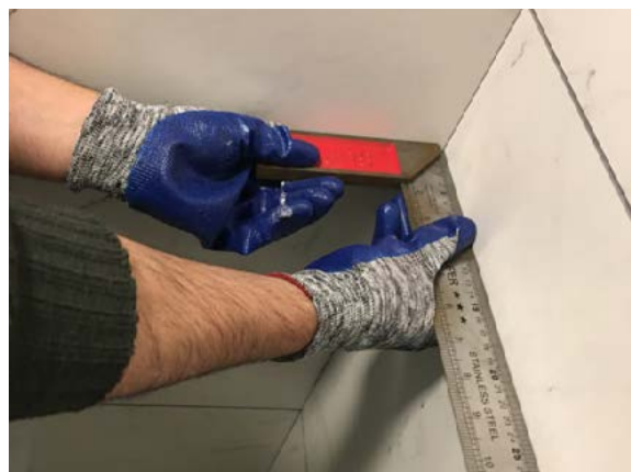
کنترل گونیا بودن گوشه‌ها
