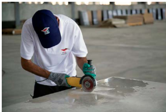
استفاده از سنگ فرز برای برش اضلاع بازشو مستطیلی
