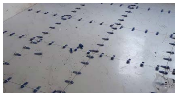
تعداد نامناسب کلیپس و گوه همترازکننده
