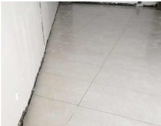
جانمایی سرامیک‌ها به گونه‌ای که قطعات برش‌خورده در مجاورت دیوار قرار گرفته و دید کمتری داشته باشند
