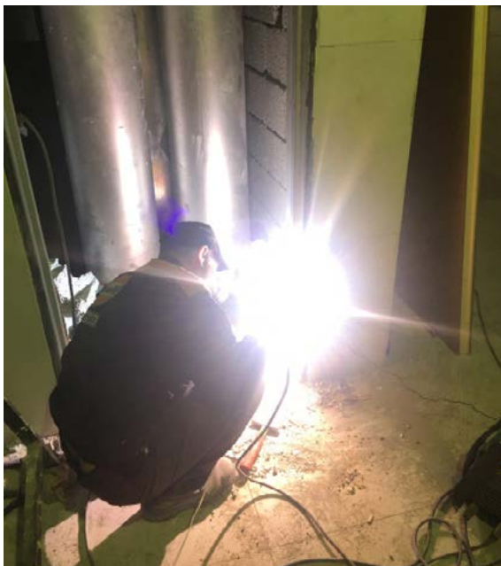
عملیات ساختمانی پس از نصب سرامیک
