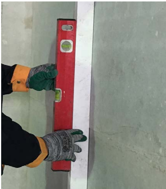
کنترل تراز بودن سطح
