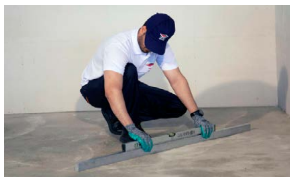
کنترل صافی و تراز بودن سطح زیرکار
