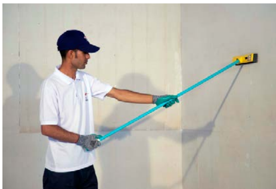
نظافت گردوغبار موجود بر روی سطح زیرکار
