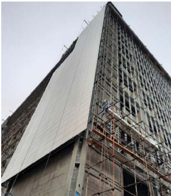
نصب خشک سرامیک بر روی زیرسازه فلزی
