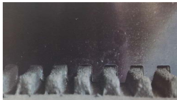
حفظ شکل دندانه‌های ماله دنداندار بر روی چسب
