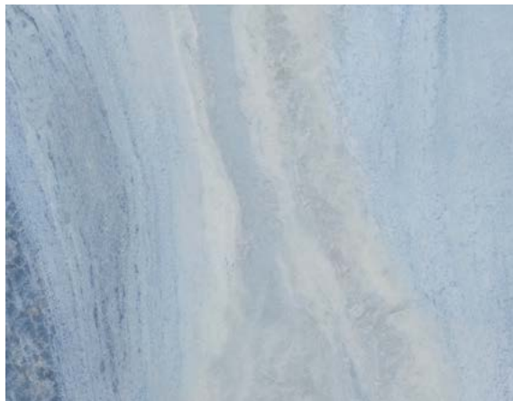
نصب سرامیک با ماله نامناسب
