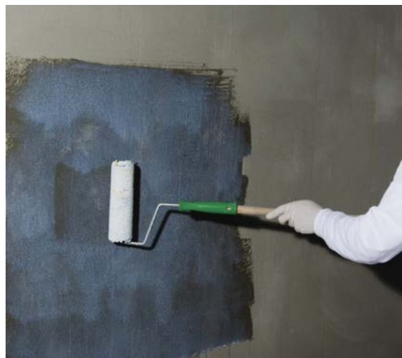
اجرای پرایمر بر روی سطح بستر با استفاده از رولر غلطکی
