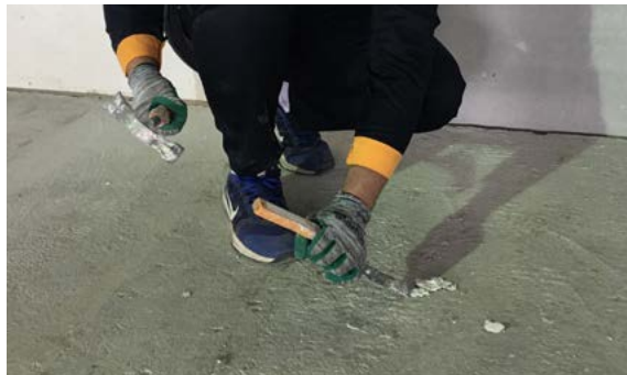
زدودن مواد اضافی سطح زیر کار به صورت مکانیکی
