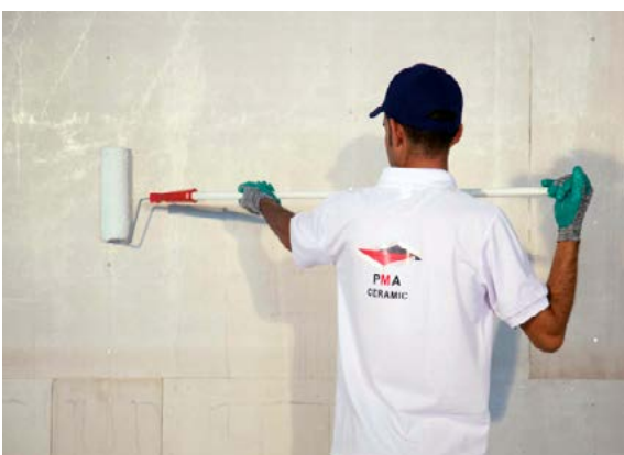
اجرای دو لایه پرایمر بر روی سطح کار
