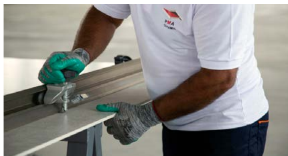
اعمال فشار یکنواخت در تمام طول مسیر برش
