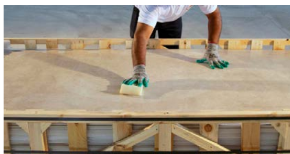
تمیز کردن سطح اسلب با پارچه مرطوب
