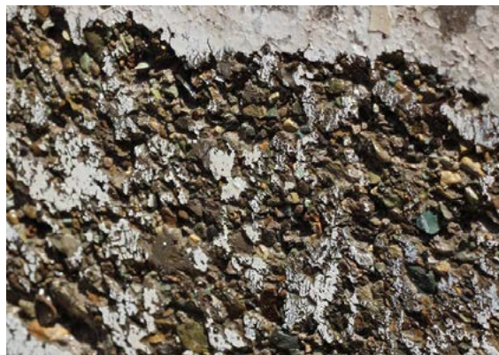
زدودن ذرات سست سطح بتنی و نمایان شدن سنگدانه‌ها
