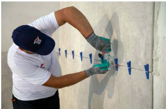
استفاده از از گُوه و کلیپس همتراز کننده برای جلوگیری از ناخن‌گیری
