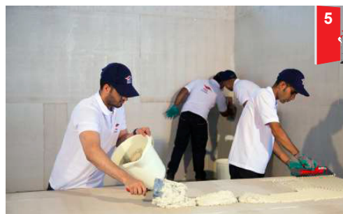
• اعمال چسب به روش combined (هم بر روی سطح و هم در پشت اسلب)
