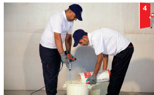
• آماده کردن چسب با استفاده از میکسر
