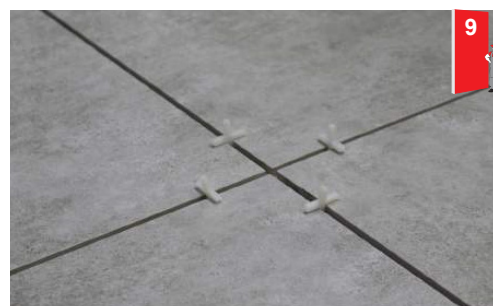
• استفاده از اسپیسر (صلیب) جهت دستیابی به بندهایی با عرض یکسان
