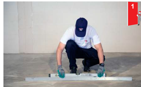
• کنترل تراز بودن و هموار بودن سطح زیر کار
