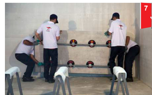
• قرار دادن اسلب بر روی سطح (استفاده از استراکچر قابی حمل مجهز به قاپک مکنده جهت حمل)
